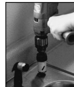
FIGURE 3 - PERÇAGE DU TROU POUR LA POSE DU ROBINET
